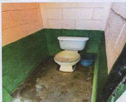
Foto7: Modulo Baños, Sustitución de sanitarios completos.
