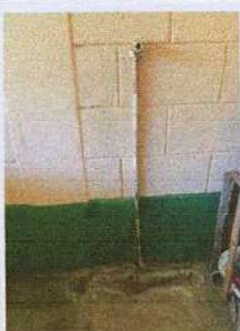
Foto 3: Modulo cocina, Sustitución de pila, drenaje y tubería de agua.
