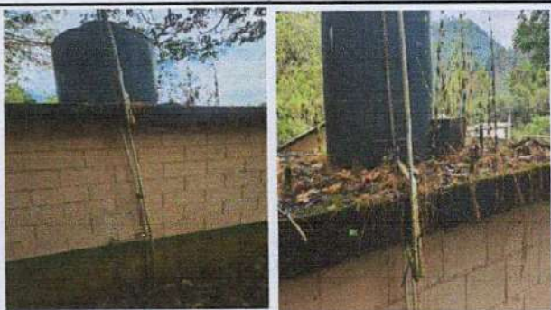
Foto 9: Modulo Baños, Sustitución de red de agua potable
