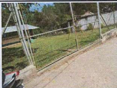
Foto 11: Modulo Patio, Sustitución de portón
