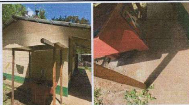
Foto 10: Modulo Baños, Sustitución de losa en pila, lamina y estructura portante de madera a metal.
