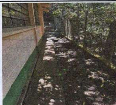
Foto 4: Modulo aula, sustitución de losa trasera.
