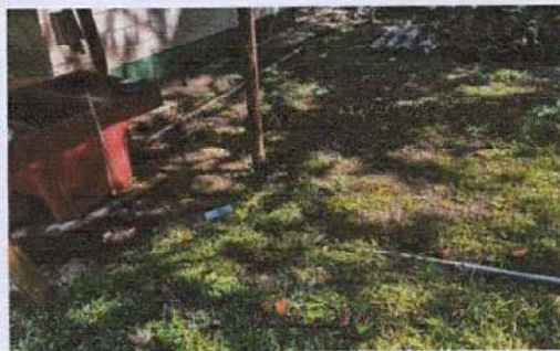
Foto7: Modulo Baños, Sustitución de drenaje y tubería en pila.
