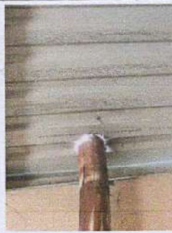
Foto 2: Modulo Cocina, Sustitución de lamina
